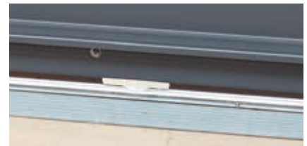
Intégration discrète du galet - La crémallière est intégrée dans le profil et laquée à la teinte du portail
