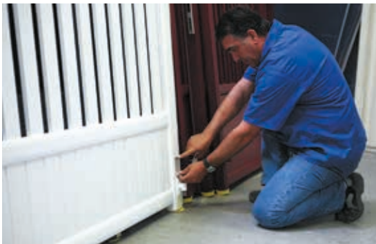
Contrôle des portails
